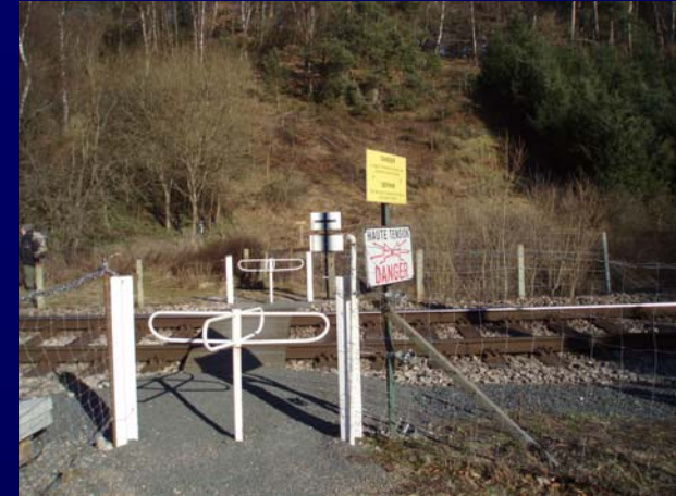
Traversée piétonne d'une voie ferrée (GR 57 - G.D. Luxembourg)
