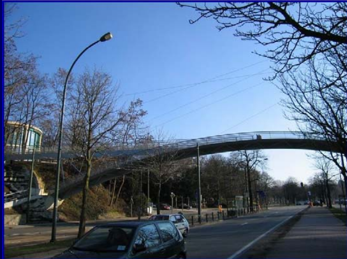
Traversée piétonne pour la RN 25 (Ligne 160 - Bruxelles)
