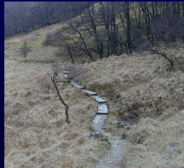
Passerelles simples pour passages marécageux
