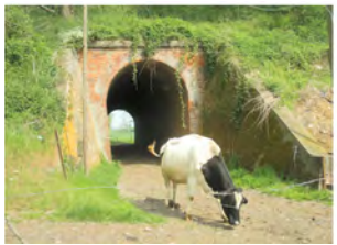
8. Tunnel sous le RAVeL
