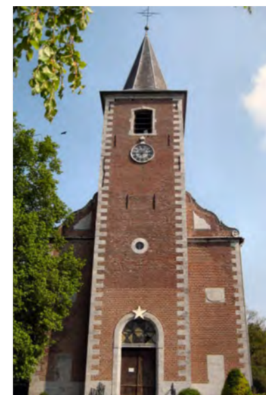
20. Eglise de Houtain-le-Val
